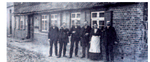
Lehrer Burmeister und seine Familie sowie ein Hilfslehrer vor dem damaligen Schulhaus. Heute ist in dem Gebäude die Kita untergebracht. Ca. 1912
